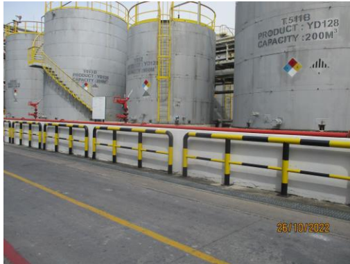
รูปที่ 34 Dike Wall/Dyke Wall
