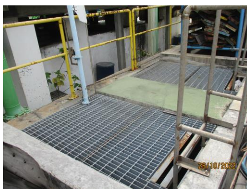
รูปที่ 15 บ่อรองรับน้ำเสียปนเปื้อนกรณีเกิดเหตุรั่วไหล
